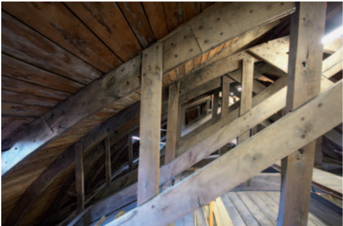
Kierspe, Margarethenkirche. Das Detail des Bohlenbalkendaches zeigt den aus Eichenbohlen zusammengesetzten Segmentbogen für die Lattung, die Ständer und die eingeklammerte Zugverstrebung.
