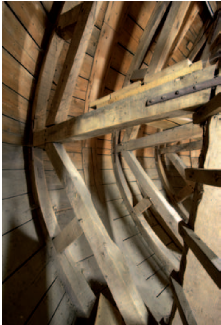
Kierspe, Margarethenkirche. Detail der Turmhaube, deren »Bauch« aus verstrebt eichernen Bughölzern gebildet wird. Horizontale Balken verbinden sie mit der konisch zur Spitze laufenden Innenkonstruktion.
